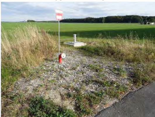
Abb. 8 „Löschwasserstelle“ im Westen des Plangebiets.
