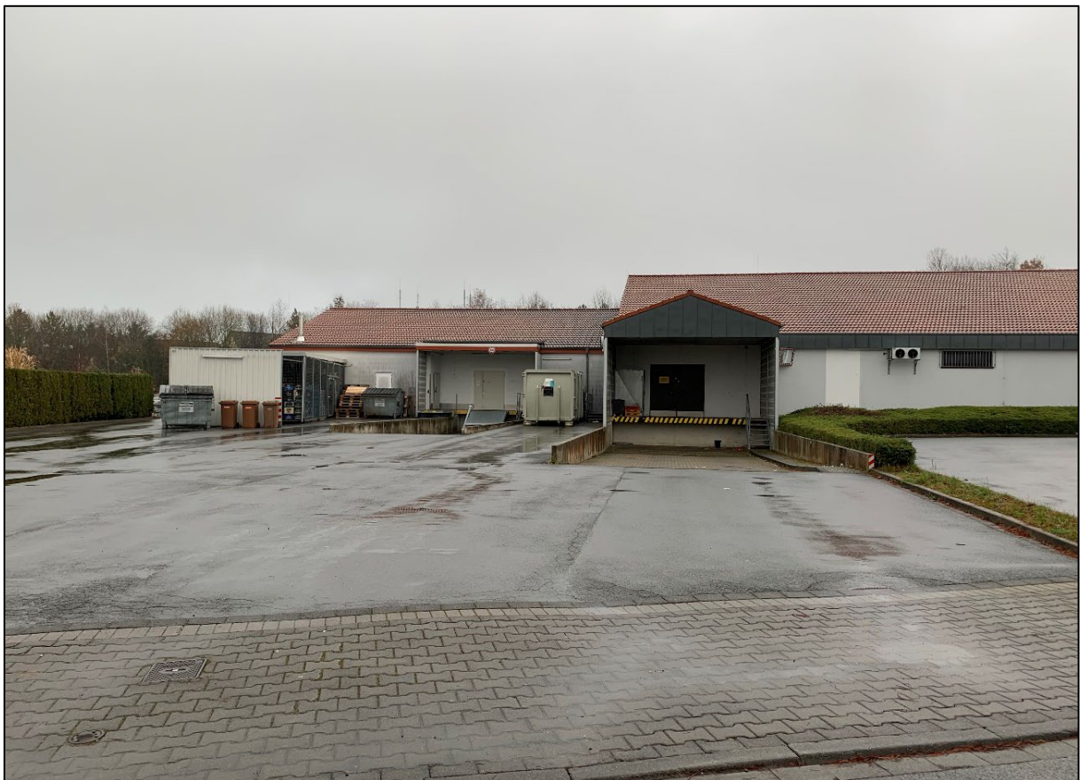
Abbildung 4: Blick auf die An- und Ablieferbereiche sowie die Entsorgungsbereiche der Märkte im Nordwesten
