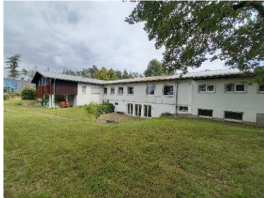
Abb. 17 Nordansicht des Haupthauses.
