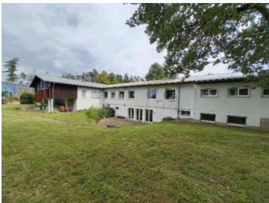
Abb. 17 Westliche Ansicht des Haupthauses.
