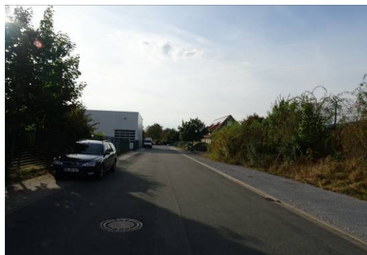
Abb. 11 Im Hintergrund Gebäude des bereits bestehenden Gewerbegebiets.
