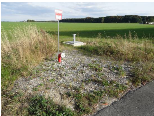
Abb. 8 „Löschwasserstelle“ im Westen des Plangebiets.
