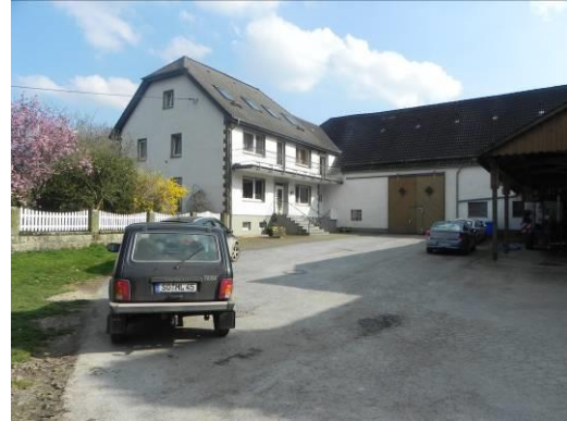
Abb. 10 Zufahrt zum vorhandenen Wohngebäude sowie Mauer westlich des Plangebiets.
