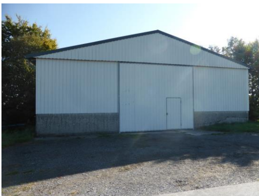
Abb. 7 Scheunengebäude im Änderungsbereich.
