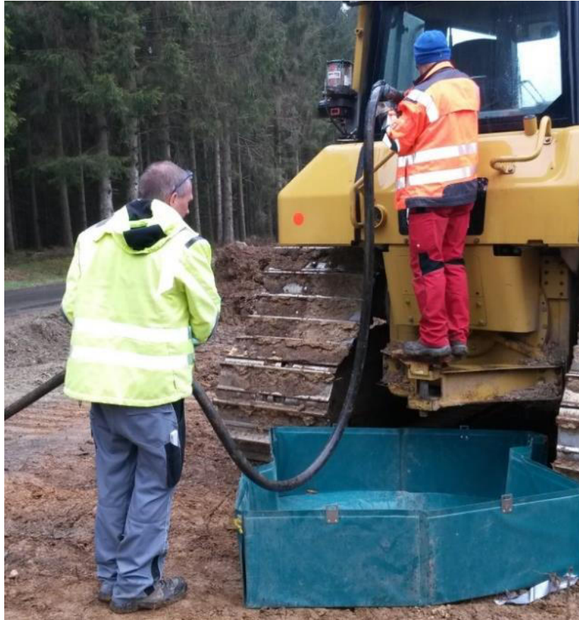
Abbildung 8: Empfohlene Maßnahme: Betankung der Baumaschinen im Bau Feld von 2 Personen mit faltbarer Auffangwanne
