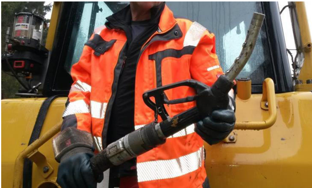
Abbildung 7: Empfohlene Maßnahme: Betankung von Baugerät mit rückschlaggesicherter Zapfpistole
