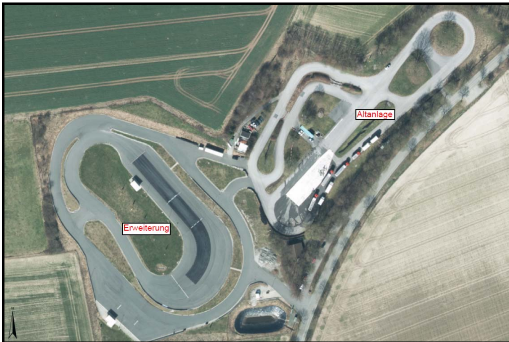
Abb. 1: Bestand des Fahrsicherheitszentrums Kaiserkuhle (Luftbildaufnahme 2017)
